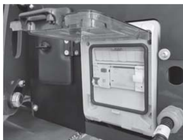
Fig. 179 Automatische magnetothermische schakelaar
