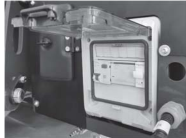
Fig. 114 Automatische magnetothermische schakelaar
